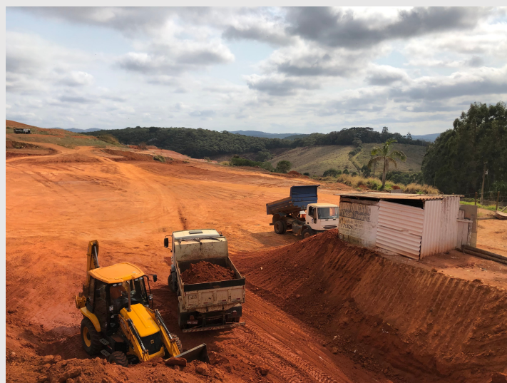
Foto: Aterro Sanitário SAAE
